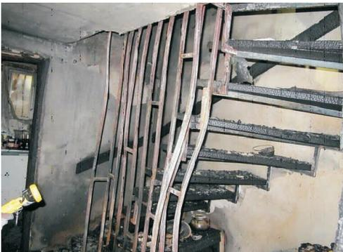
Foto FF NIS: Die von der Hitze des Brandes verformte Metallkonstruktion der Treppe.
